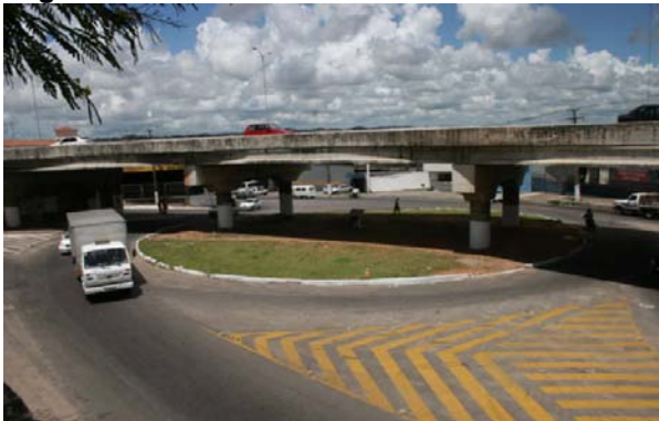
Figura 12 – Viaduto da urbana
