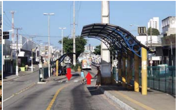
Figura 15 – Corredor exclusivo de ônibus na av. Bernardo Vieira
