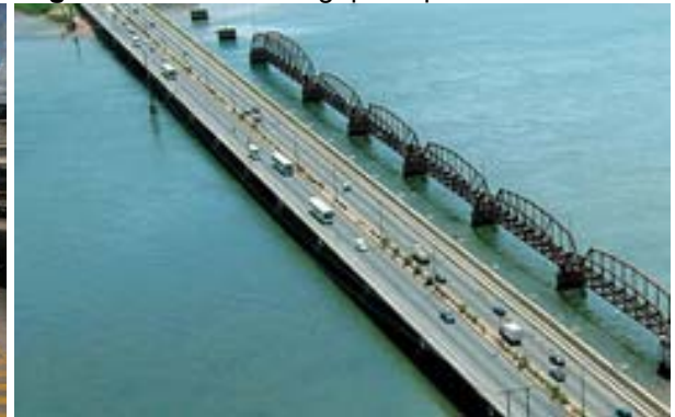
Figura 13 – Ponte de Igapó duplicada
