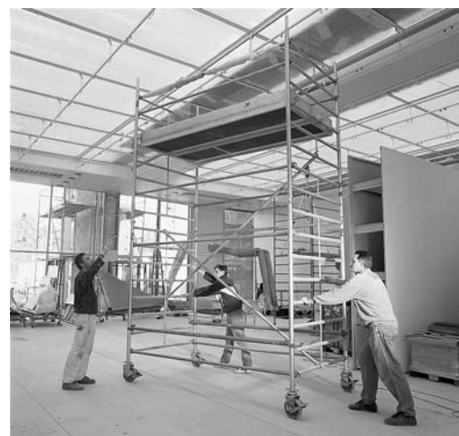
Fig. 5: l'échafaudage roulant ne doit pas être déplacé lorsque des personnes se trouvent dessus.
