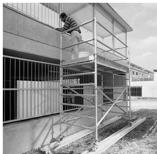
Fig. 2: un support résistant empêche l'échafaudage roulant de s'enfoncer brutalement.
