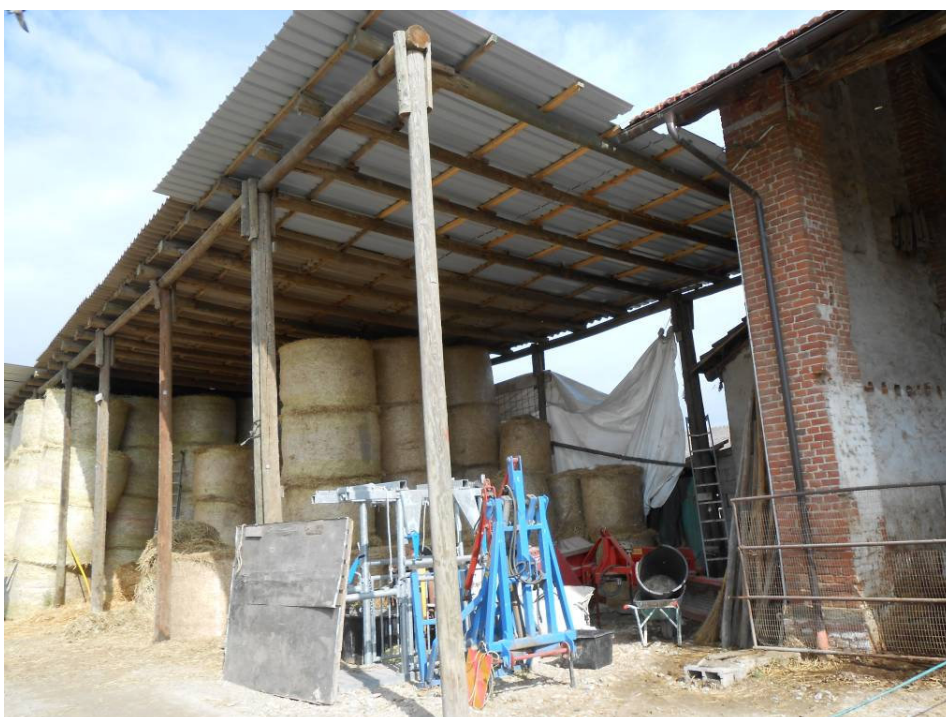
Foto n. 20 – Particolare della tettoia “C”
