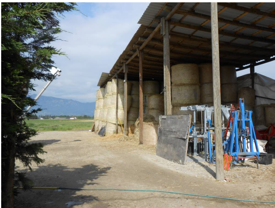
Foto n. 21 – Parte della tettoia “C” e tettoia non autorizzata
