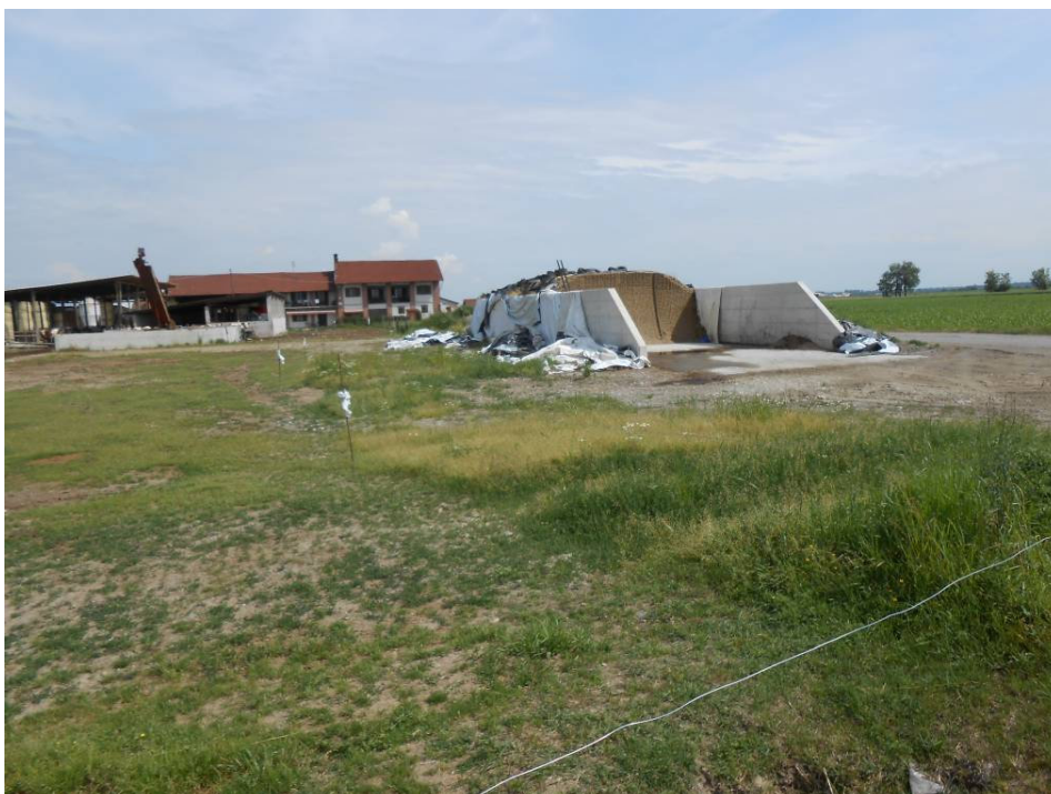
Foto n. 27 – Silos a platea
