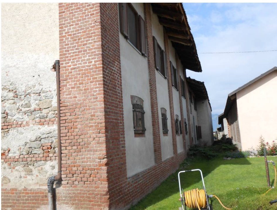
Foto n. 2 – RetroProspetto Nord del fabbricato principale di abitazione
