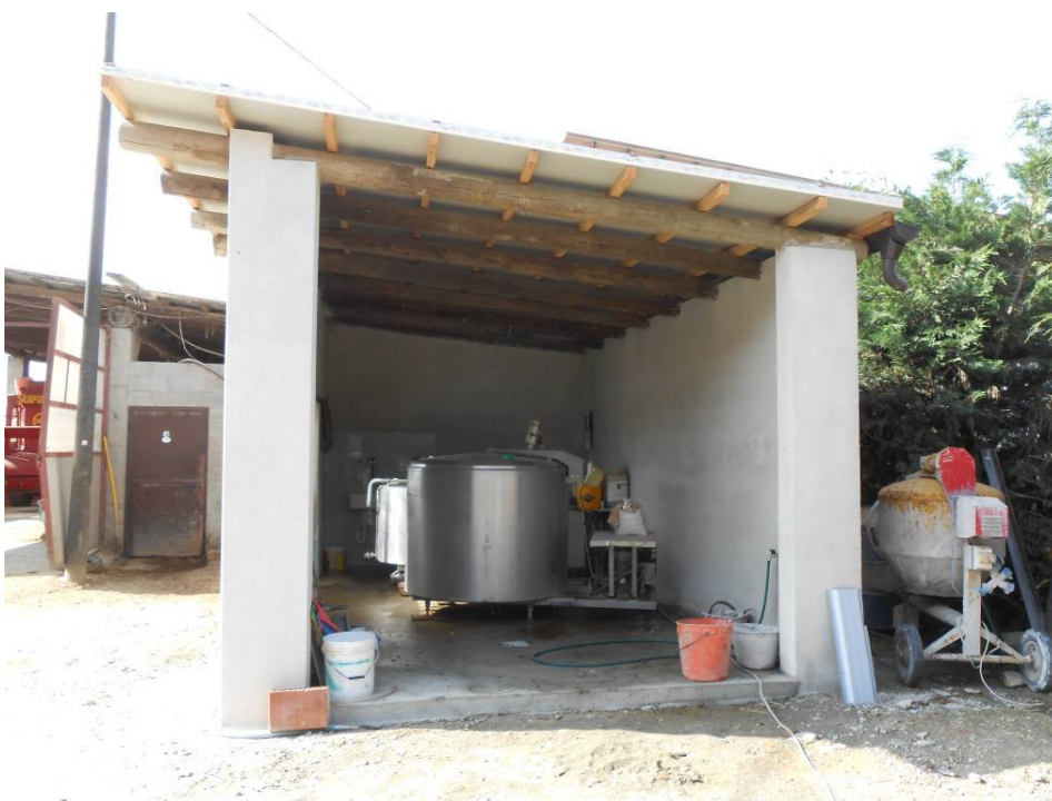
Foto n. 24 – Particolare della sala refrigeratrice
