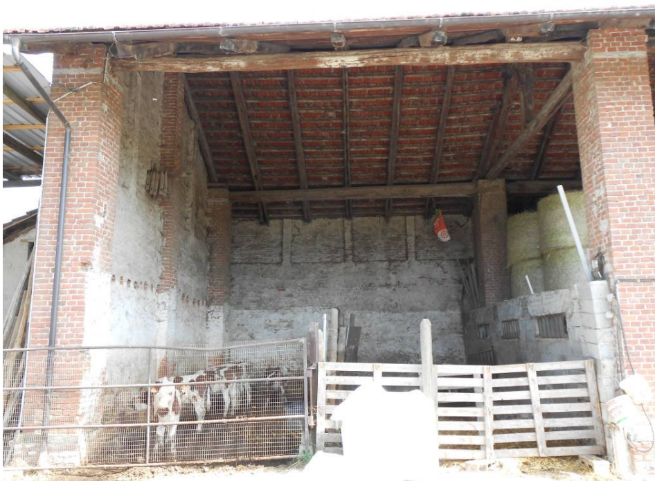
Foto n. 19 – Particolare della tettoia “B”
