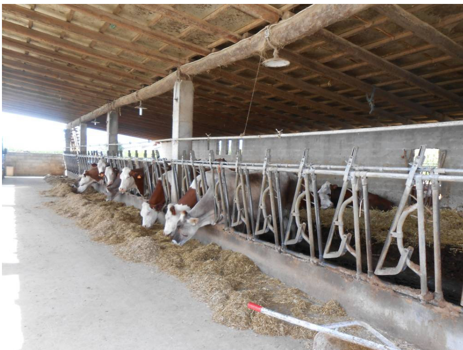
Foto n. 23 – Particolare della stalla
