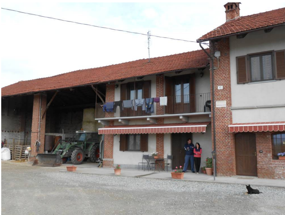
Foto n. 9 – Prospetto Sud del fabbricato secondario di abitazione (su cortile)
