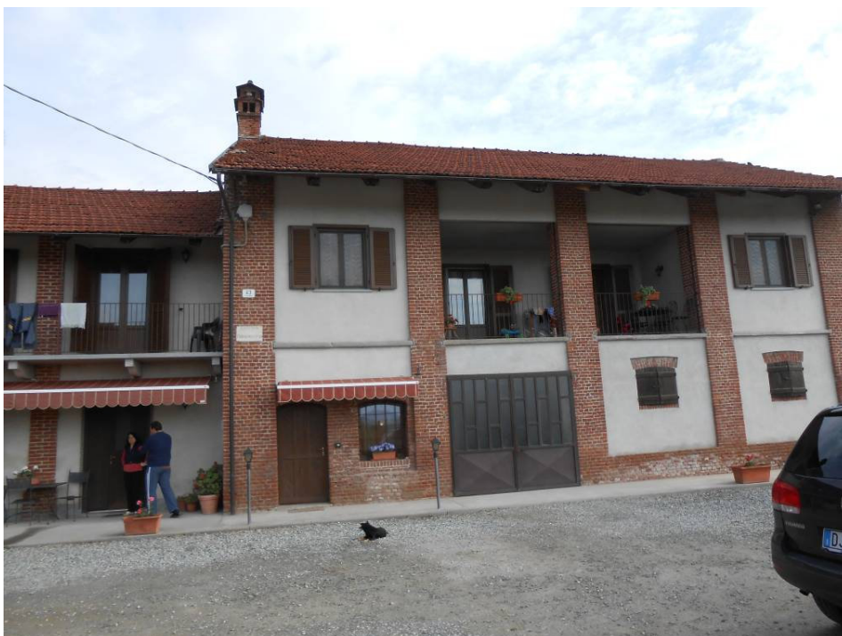
Foto n. 1 – Prospetto Sud del fabbricato principale di abitazione (su cortile)
