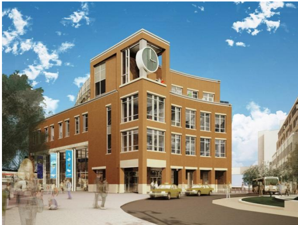
Normal, IL Multimodal Transportation Center
