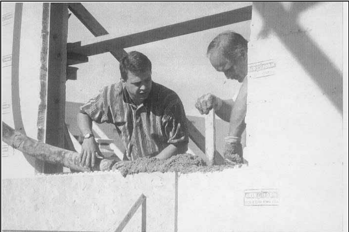
Photo 35: Site #3 - Concrete Pour at Window
