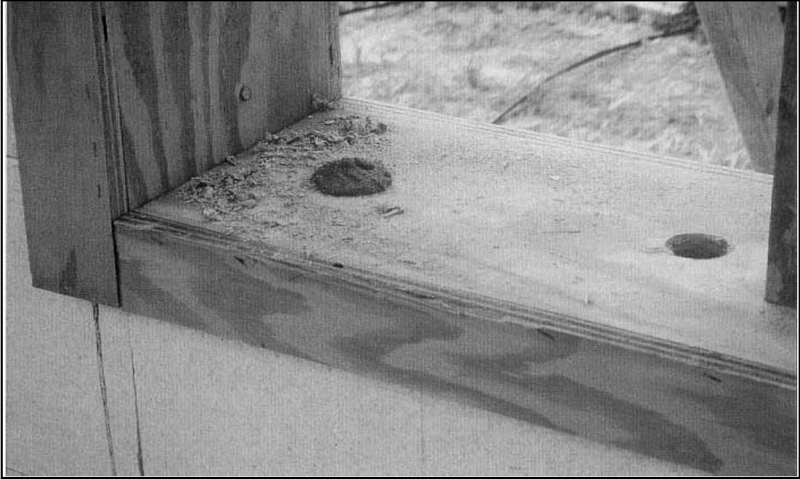
Photo 53: Site #4 - Concrete Pour at Window
