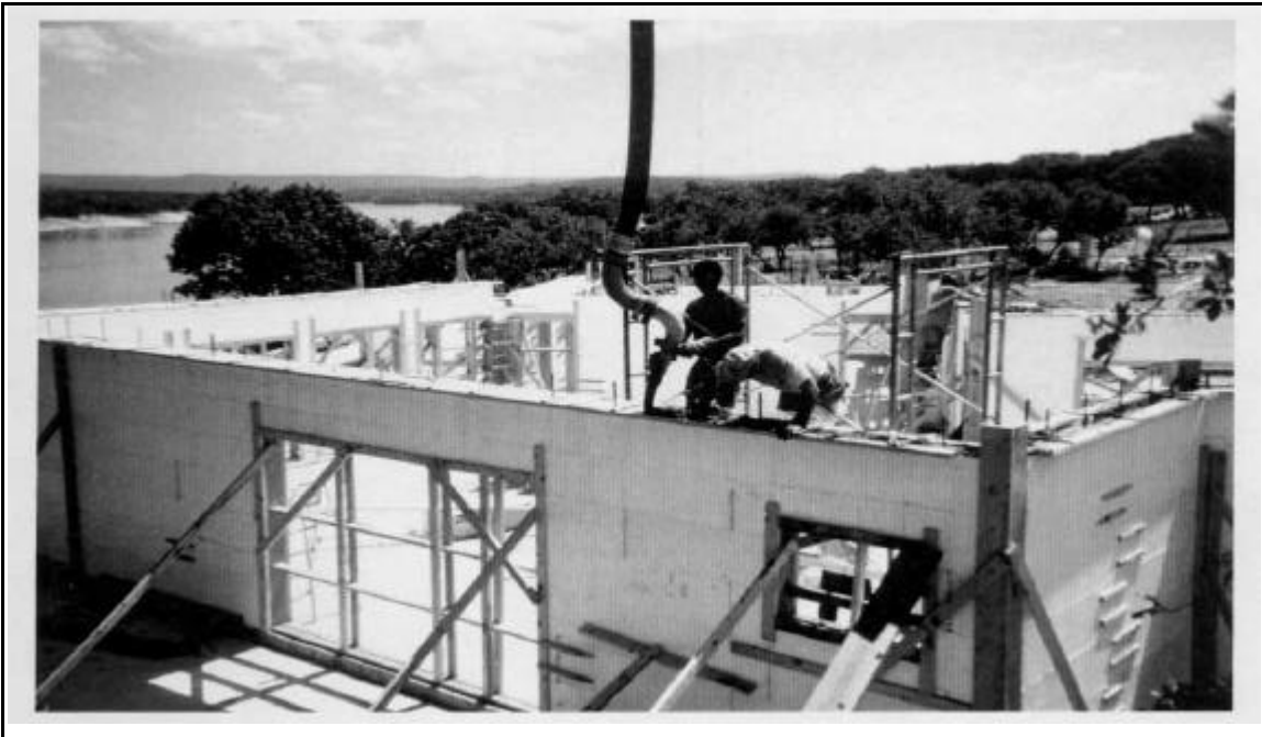
Photo 18: Site #2 - Concrete Pour
