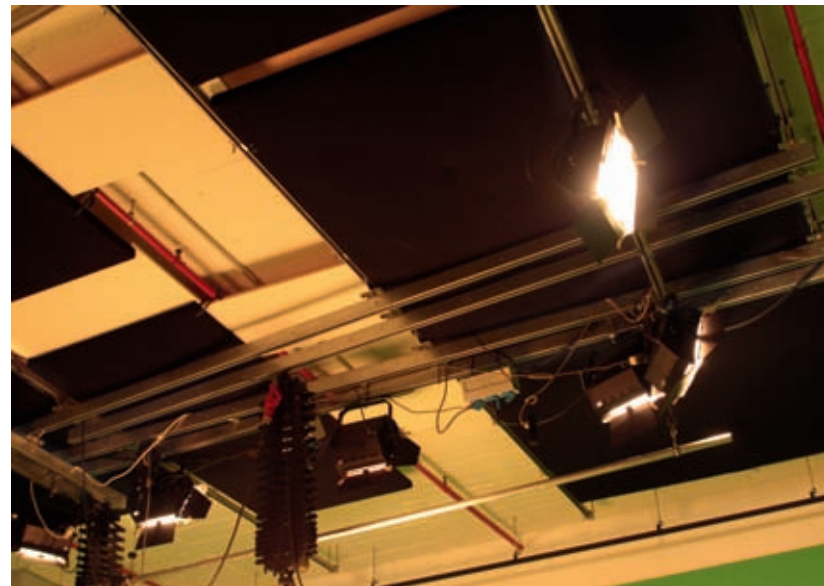
Sieben auf einen Streich: Die asymmetrischen Leuchten von Arri schaffen ein homogenes Licht für die Greenscreen
