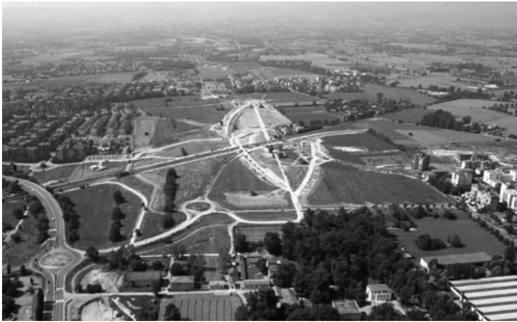
Reggio Emilia, Parco Ottavi, il grande parco in costruzione
