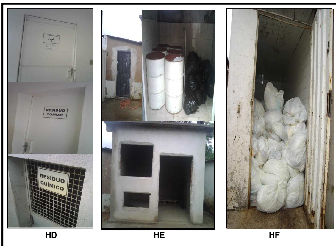
Figura 4.5b – Abrigos externos dos RSS dos hospitais D, E e F
