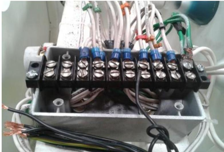
*Figura 15 Tablilla doble contacto para conectar cable múltiple*
