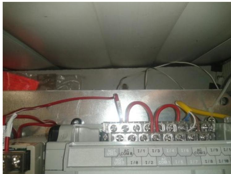
Figura 21 Cableado del plc en el AC/ COM 0, 1 y 2
