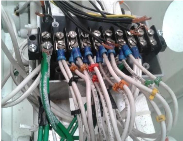
*Figura 12 Cableado por pares e identificado por número de colores*
