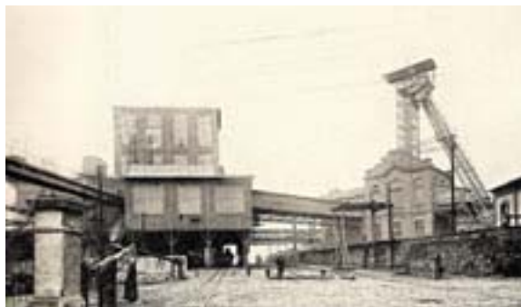
Jáma Trojice s úpravnou uhlí v roce 1928
