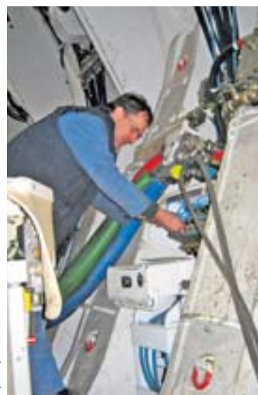
Servisní technik při opravě hydraulické výztuže
