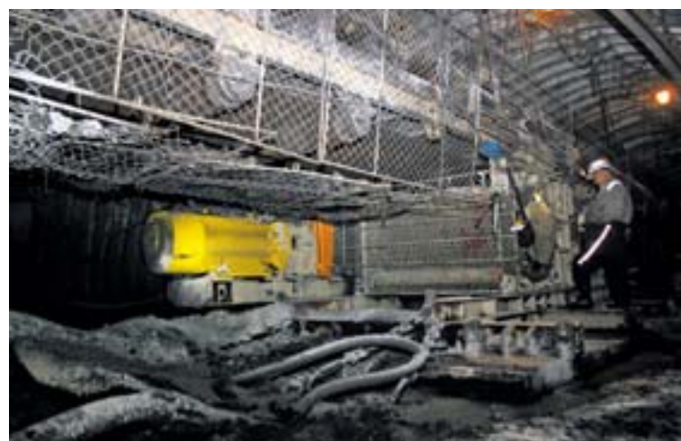
Instalace nových pásových tratí zlepší a zrychlí odtěžení.
