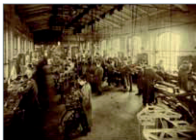
Montage und Mechanikfertigung in Göttingen um 1910
