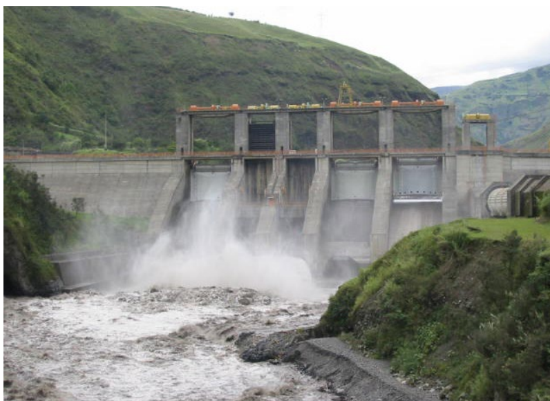
■ Una delle centrali idroelettriche del distretto di Cochabamba
