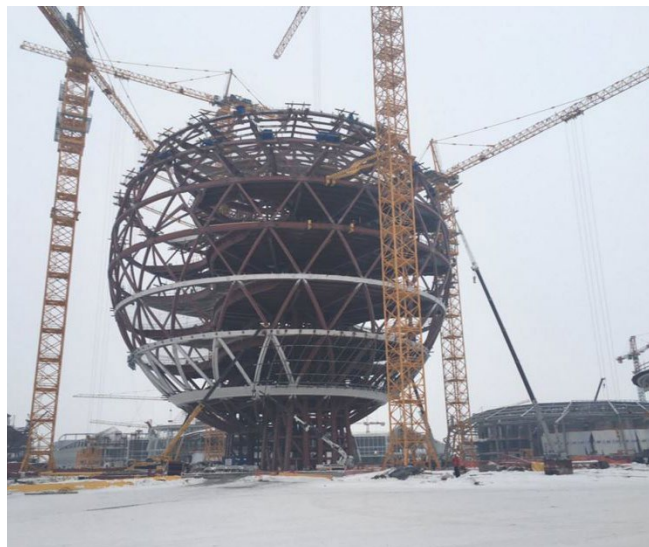
■ Una fase della costruzione del futuro padiglione kazako all'Expo 2017
