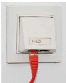
Abbildung 2 Kategorie 6 Datenanschlussdose mit zwei RJ-45 Buchsen
