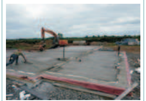
Pour the Concrete Floor
