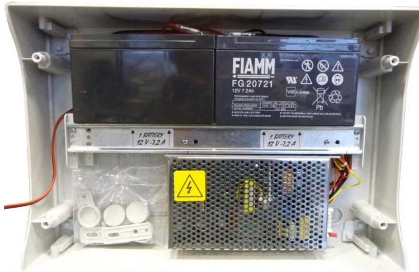
Conecte un cable de tres hilos (mínimo 1,5mm<sup>2</sup> para cada polo) a la tarjeta de alimentación y fíjelo con una brida de sujeción adecuada. Instale un interruptor dedicado en el cuadro eléctrico general para el control de la alimentación principal 220Vca de la central de gas. Antes de suministrar tensión al sistema, conecte todos los detectores a la central. Tras conectar la central, conecte a continuación las baterías.
