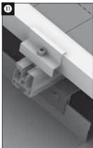
Figura 3 – Fixação dos módulos fotovoltaicos por pressão
