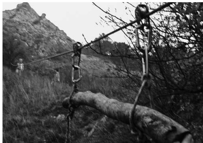
△ Bau einer Seilbahn
