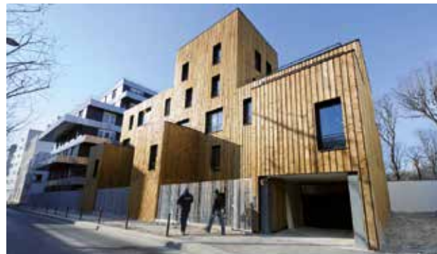
Des opérations de rénovation urbaine (ici à Paris) prennent toute leur place dans une approche environnementale de l'urbanisme.
