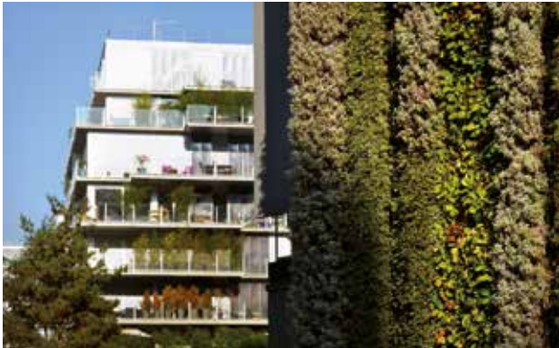
Mur végétal en ville, pour rafraîchir l'atmosphère et limiter l'absorption de chaleur.
