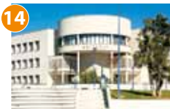
14 EDIFICI DE RECTORAT
