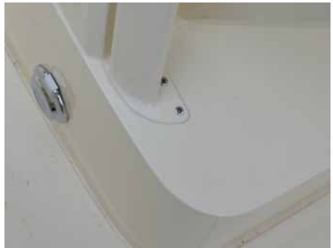
120-Volt Power Inlet
