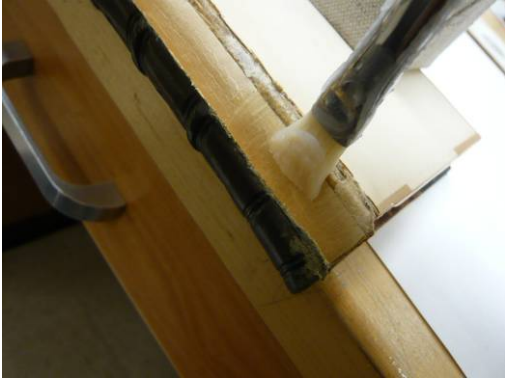
【 Pasting the cloth hinge down 】
