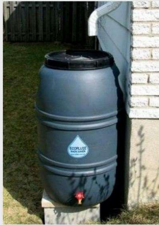
Un baril de récupération d'eau de pluie placé sous une gouttière. (Photo : archives)
