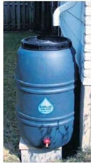
Un baril de récupération d'eau de pluie placé sous une gouttière. (Photo : archives)
