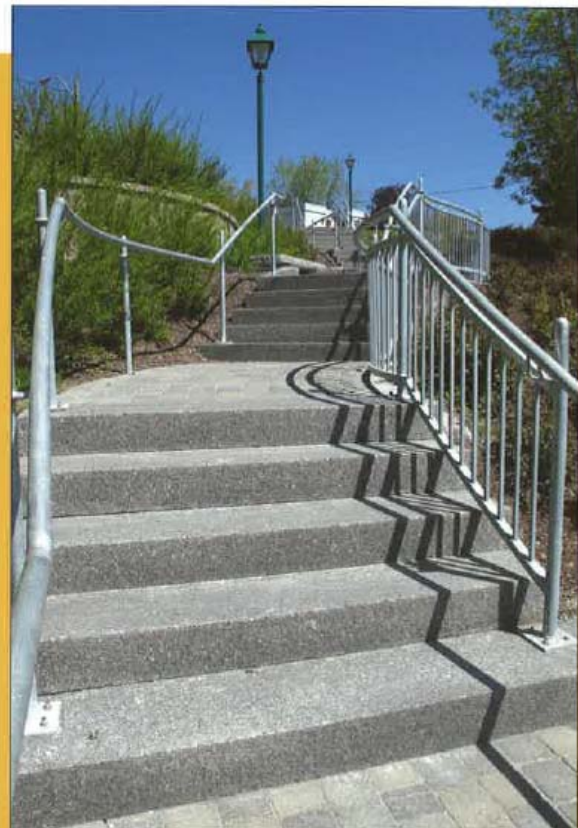
Escalier extérieur avec contremarches fermées
