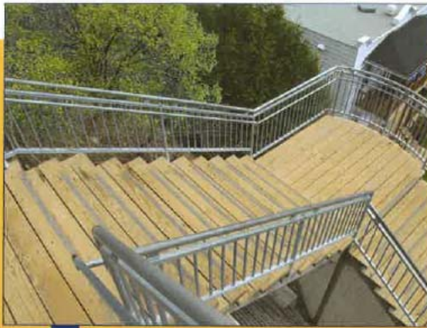
Escalier extérieur à contremarches ouvertes
