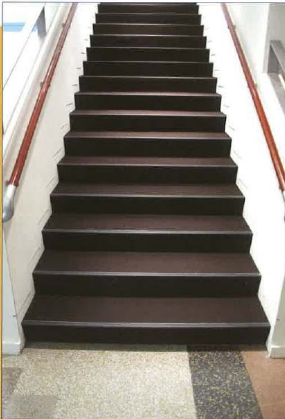
Escalier intérieur avec contremarches fermées
