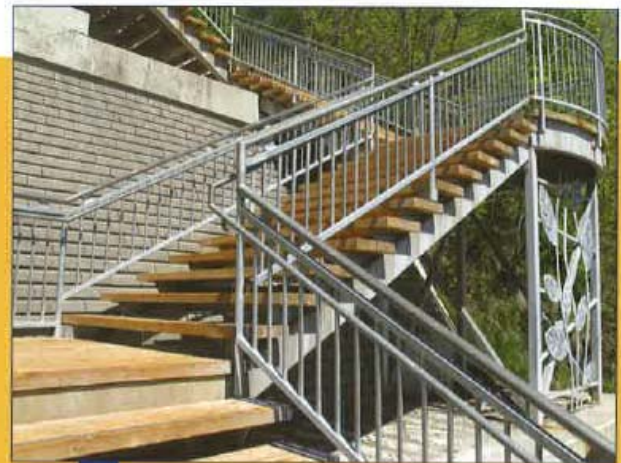
Escalier extérieur à contremarches ouvertes
