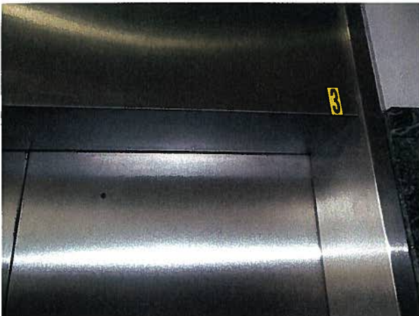
MISSING HOISTWAY DOOR ESCUTCHEON
