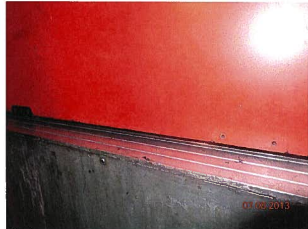
HOISTWAY DOOR MISSING GIB
