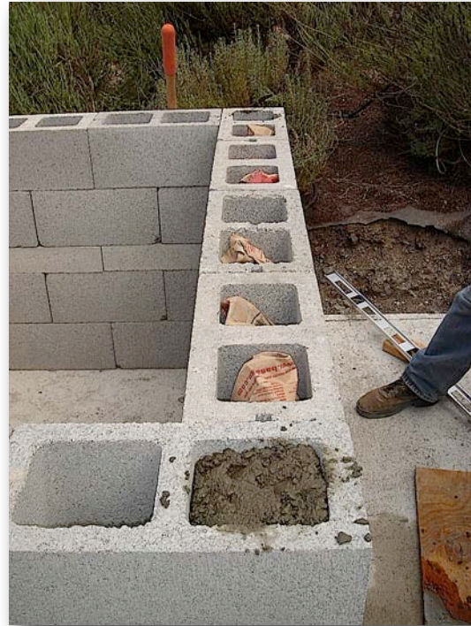
2.7. Filling the cores.
