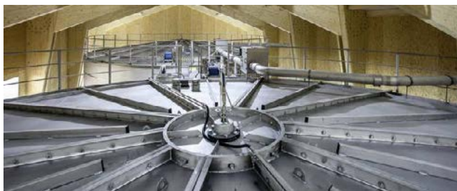
Spiral-welded stainless steel reservoirs erected on site. Source: Bayerische Staatszeitung / Wasserversorgung Bayerischer Wald (Germany), bayerische-staatszeitung.de
