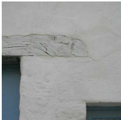
Façade entièrement badigeonnée
