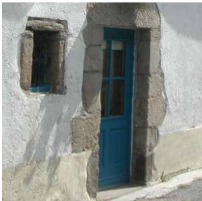
Enduit avec badigeon de chaux
