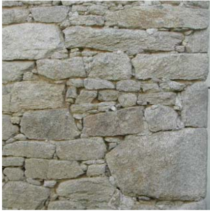
Moellons apparents à joint sec
