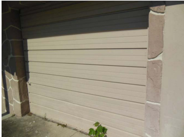
Repair or Replace Garage Door
