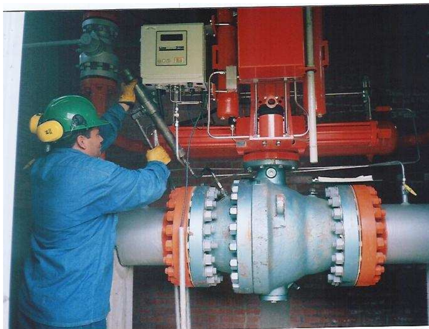
Figura 10. Válvula con actuador Bettis K14+000
