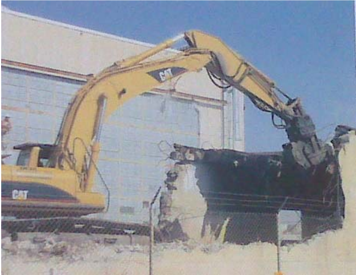
Figure A.10. Concrete Demolition (Pulverizer)
